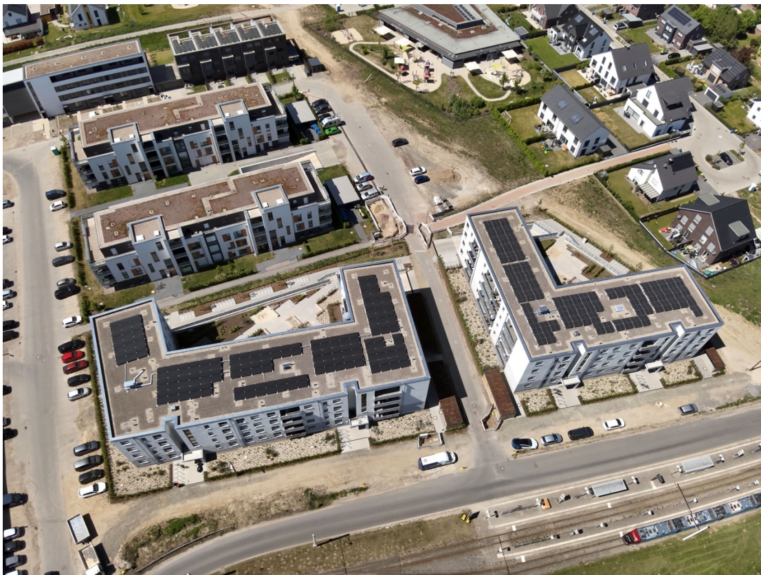
Foto: Energiegenossenschaft Braunschweiger Land eG
