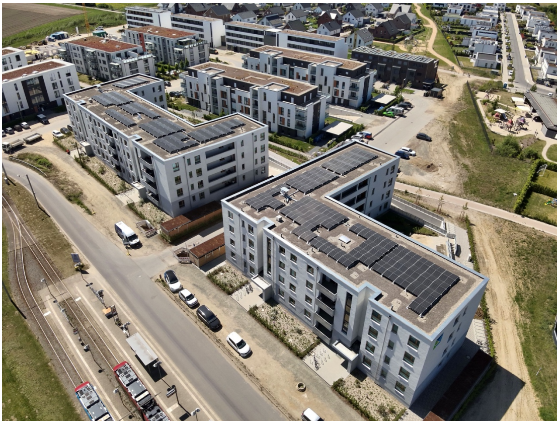
Foto: Energiegenossenschaft Braunschweiger Land eG
